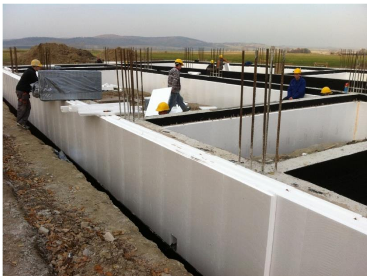
Zdjęcie 2. Wykonanie izolacji termicznej ściany fundamentowej.
