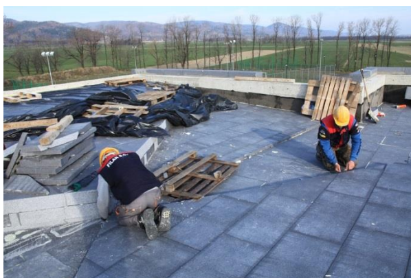
Zdjęcie 10. Warstwowe układanie izolacji termicznej dachu w celu likwidacji mostków termicznych i parowych występujących na połączeniach między płytowych.
