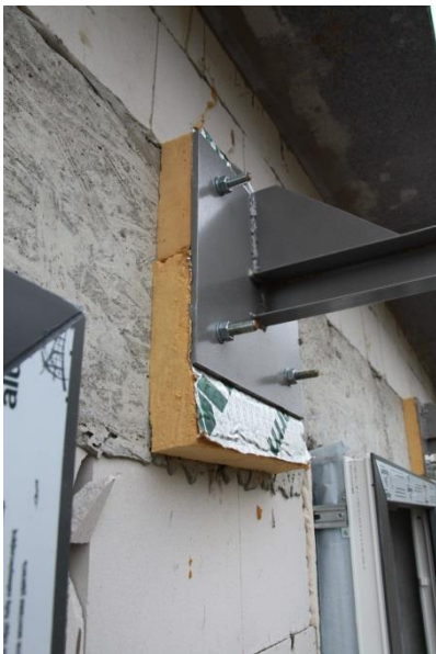
Rysunek 11. Połączenie łamacy światła ze ścianą przechodzące przez izolację termiczną. Wątpliwości budzi przyjęte rozwiązanie i jej wpływ na miejscowe osłabienie termiczne.
