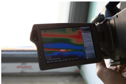
Zdjęcie 5. Kontrola termowizyjna szczelności poszczególnych elementów budynku podczas próby szczelności.
