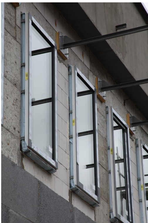
Zdjęcie 7. Mocowanie stolarki na konsolach wraz z taśmami uszczelniającymi jednowarstwowymi.
