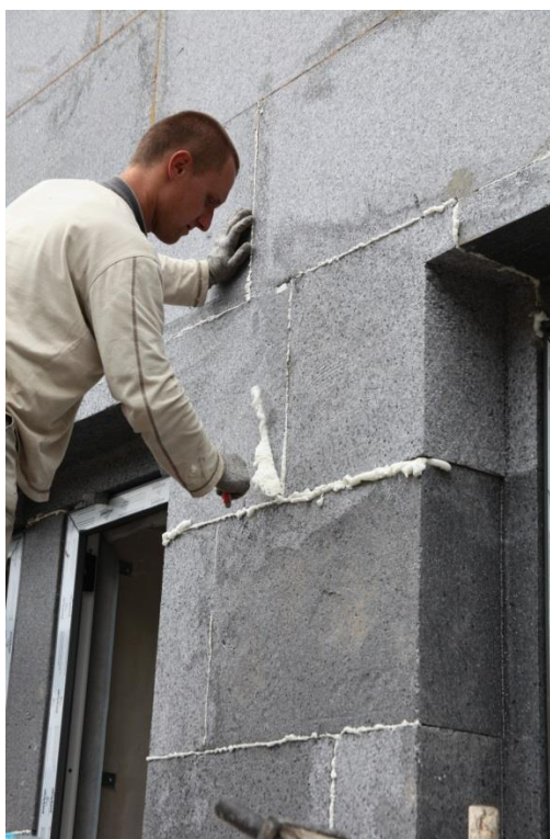
Zdjęcie 8. Wykonanie izolacji termicznej ściany – prace zapewniające ciągłość izolacji termicznej i likwidację mostków termicznych oraz parowych na połączeniu płyt termoizolacyjnych.
